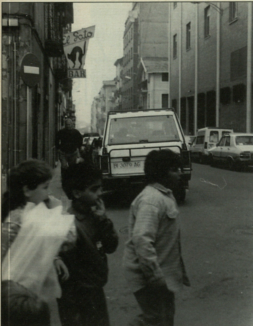
Hondamen politikak eta jarraikako narriadurak asko merkatu ditu etxeak.(A.: I. Diaz de Durana).
