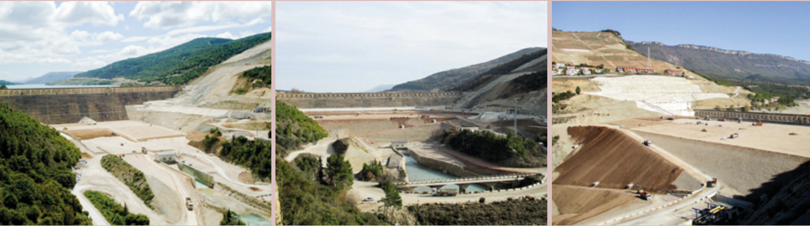
Materialez eraikitako presaren eraikuntza hiru une desberdinetan. / ARGAZKIAK: CHE
