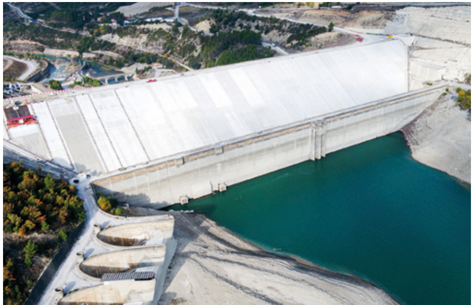
Lehen planoan ikusten da hormigoiko presa zaharra, urarekin kontaktuan, eta bigarrean handitze lanetarako materialez eraikitakoa. / ITURRIA: CHE
