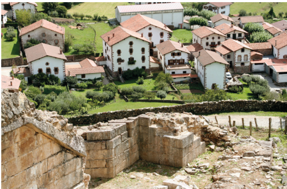
Gazteluaren aztarnak eta Amaiurko herria tontorretik. 1522ko borrokaldiaz gutxi badakigu, are gutxiago dakigu herritarrek bizi izandakoaz. URKO APAOLAZA
